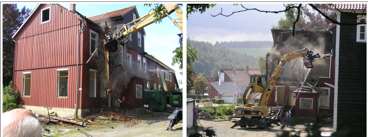
Der Abriss des „Roten Hauses“
