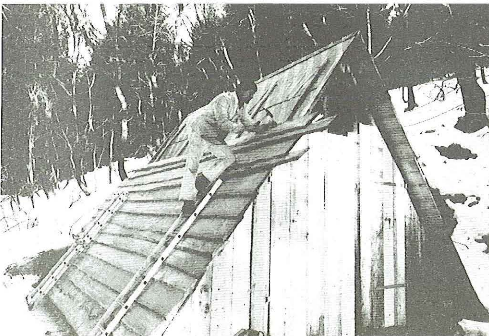
Das Huthaus in der Pinge über dem Blindschachthaspelraum. Holzbeschlag mit Dichtbahn und Deckung mit unbesäumten Brettern
