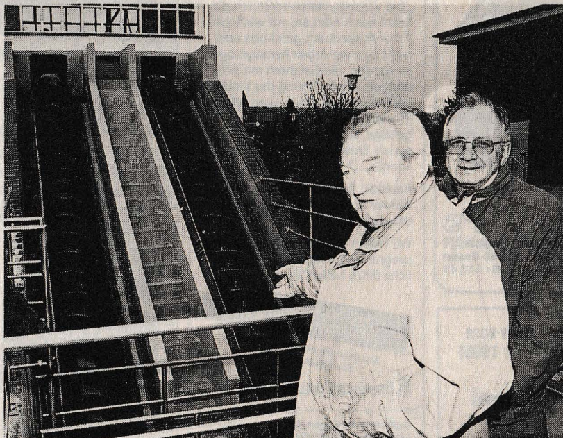
Nach einem Dreh mit dem Zentralschlüssel setzten sich die beiden Schnecken des Pumpwerkes in Bewegung. Interessierte Beobachter sind hier Herbert Schlieff und Horst Hörseljau.
