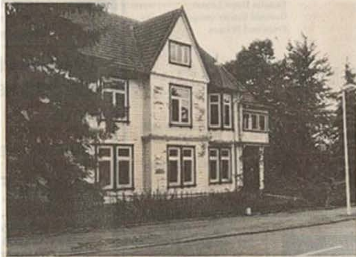
Ehemals „Haus Bremen“, später Arztwohnhaus, seit Jahren unbewohnt und dem Verfall preisgegeben; Jetzt soll es abgebrochen werden.
