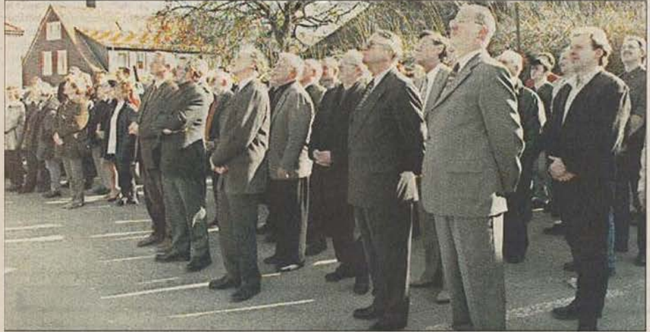
Eine große Gästeschar, darunter außer den „Offiziellen“ und Handwerkern auch Nachbarn sowie Mitarbeiterinnen und Mitarbeiter, verfolgen bei herrlichem Sonnenschein den Richtspruch des Zimmermanns und Poliers. Foto: Meier-Cortés
