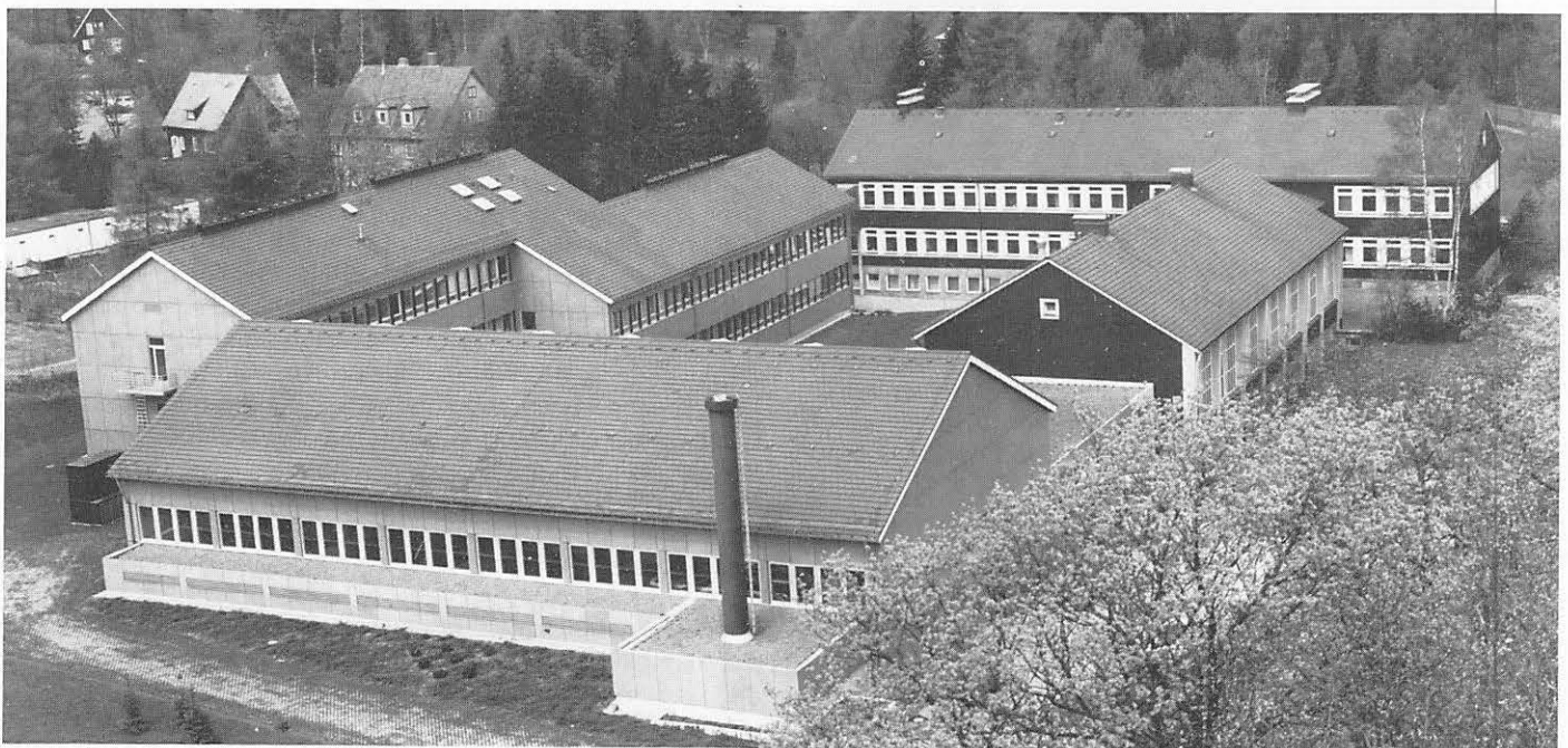
Das Metallurgische Zentrum der TU Clausthal, gesehen aus südlicher Richtung.
