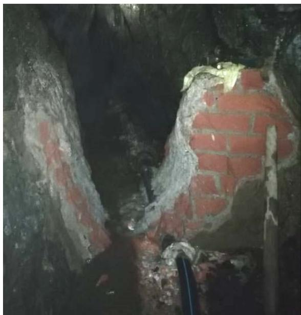
St. Annen Stollen, geschlitzter Damm nach Verlegung der Wasserfassung
