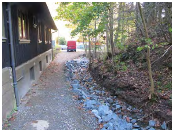
Die nächste Schneeschmelze kann kommen: Hochwasserschutz im Kälbertal
