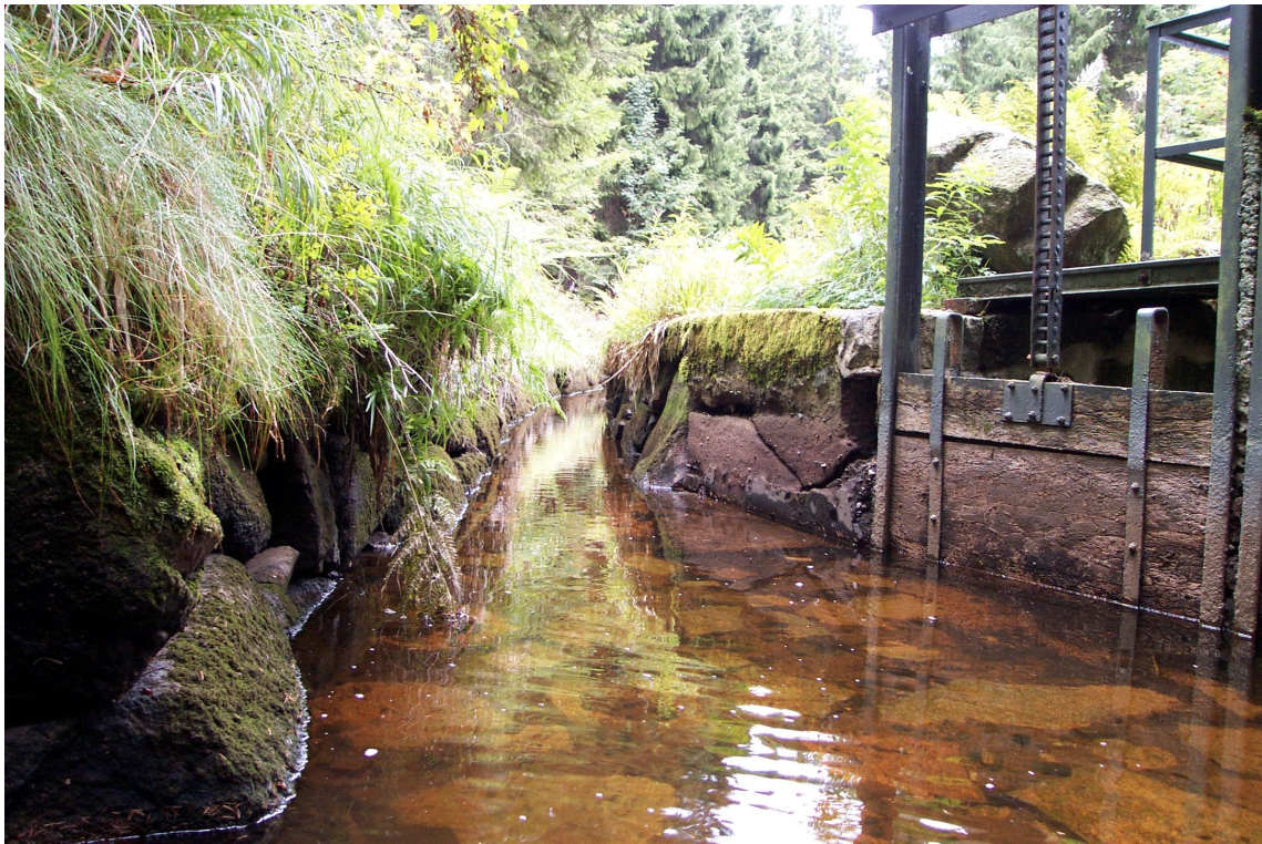
Abbildung 1: Ein Schütz am Rehberger Graben
