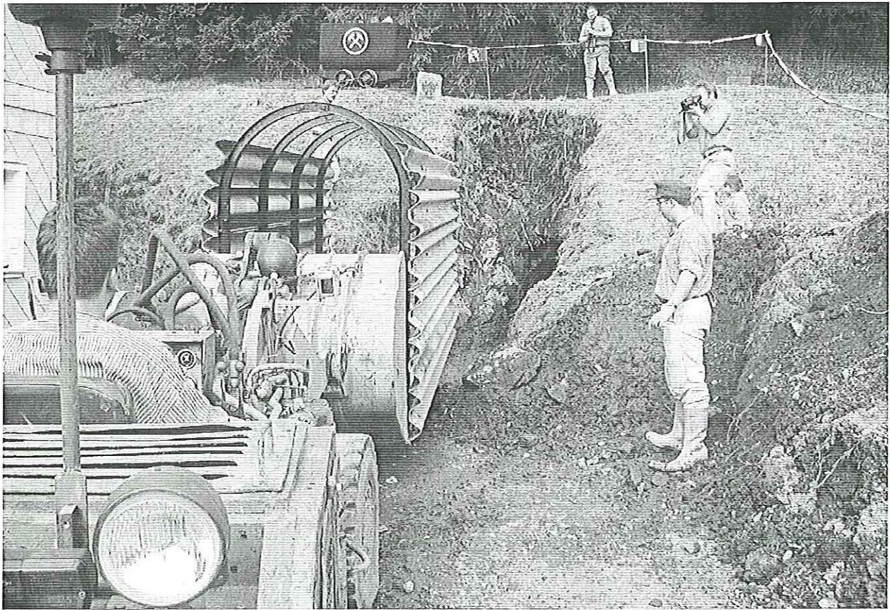
Einrangieren des über vier Meter langen vorgefertigten Ausbausegmentes
