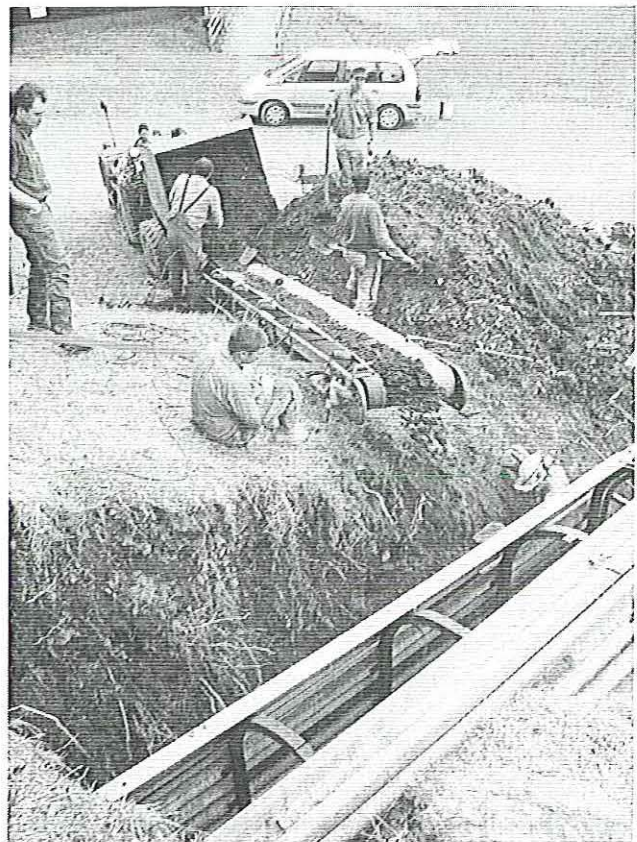
Verfüllen des Erdreiches auf dem Mundloch
