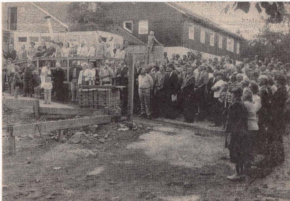
Eine stattliche Kulisse bei diesem außerordentlichen Richtfest.
