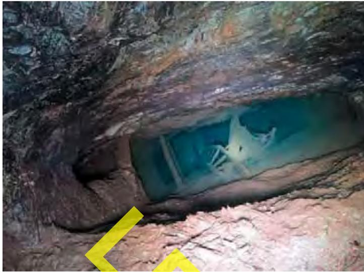
Abb. 6-18 d: Das mit Wasser gefüllte „blinde“ Gesenke auf dem Jacobsglücker Gang im St. Jürgener Feld, vermutlich bis zu 10 m tief; darin konserviert sind hölzerne Einbauten und Fahrten; auf der 7-Lachter-Strecke, hier ist aufgrund anhaltender Trockenheit im Sommer 2020 der Wasserspiegel um rund 2 m abgesenkt (Blick senkrecht nach unten).
