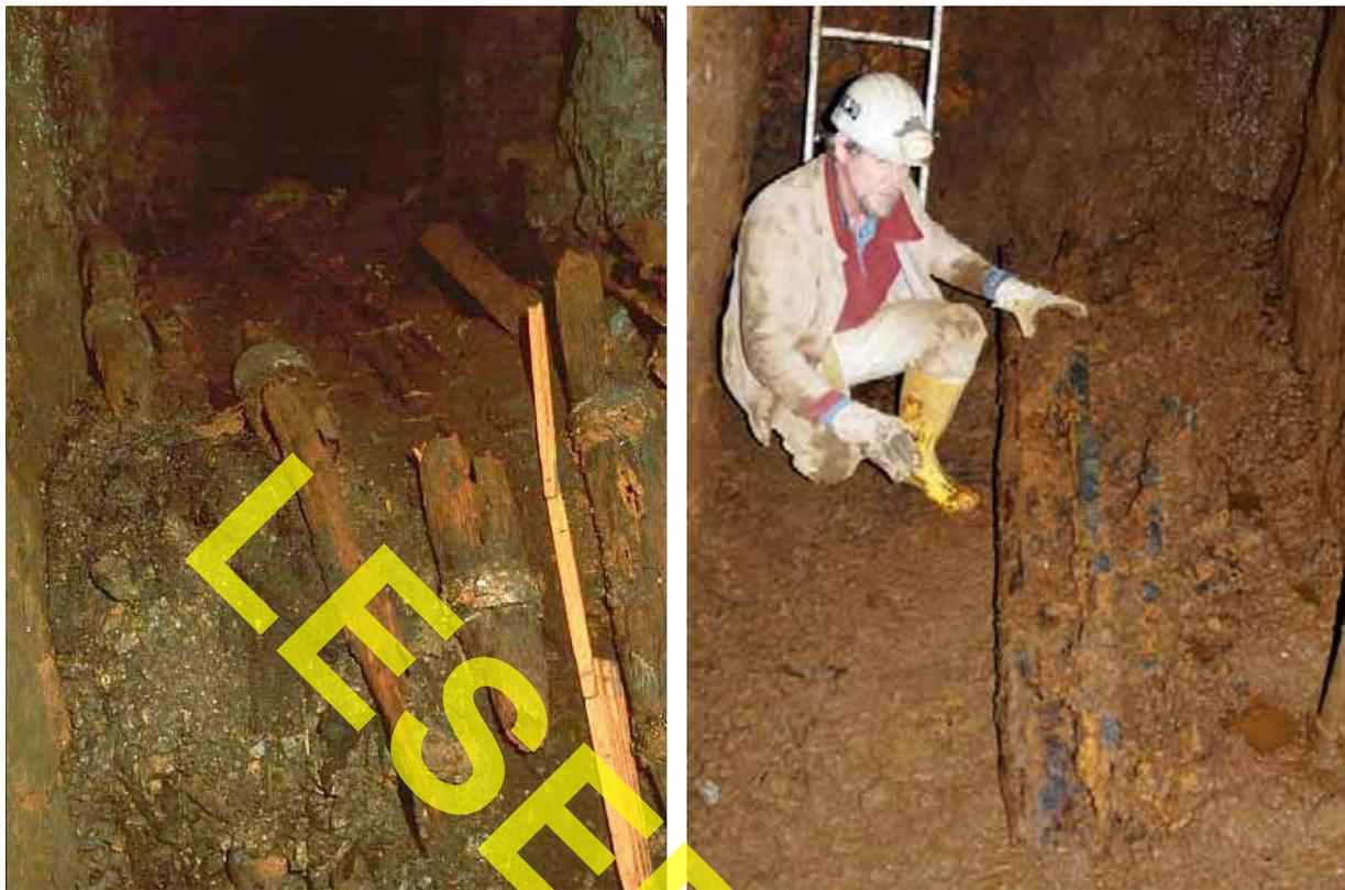
Abb. 2-15 a: Gestängereste der Wennsglückter inwendigen Kunst, gefunden 1996 bei der Auswältigung des Tagesstollen Feldortes. b): 2007 in den Strossen nordwestlich vom Kunstschacht (42 m u. T.) geborgene Reste eines Halbgerennes, in welchem einst das Wasser auf der unteren Geschleppstrecke der Pumpenkunst zugeführt wurde.
