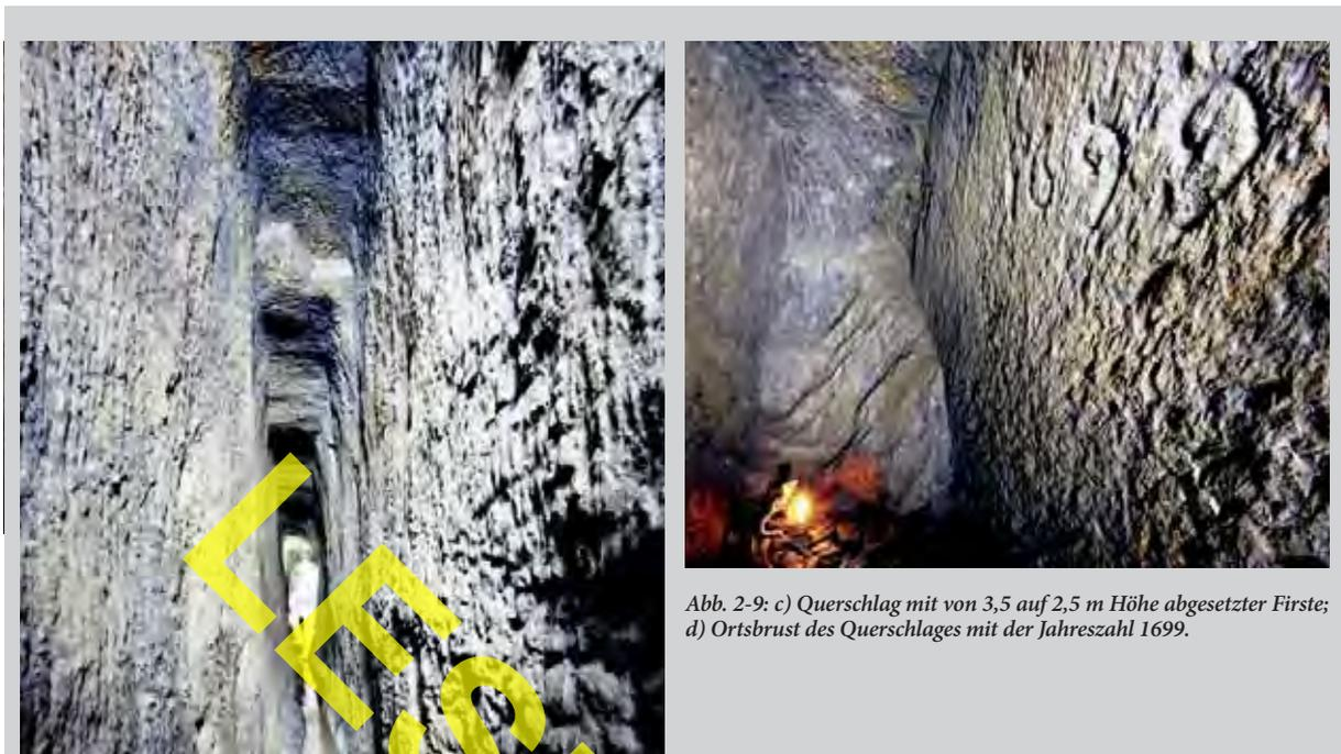
Abb. 2-9: c) Querschlag mit von 3,5 auf 2,5 m Höhe abgesetzter Firste; d) Ortsbrust des Querschlages mit der Jahreszahl 1699.
