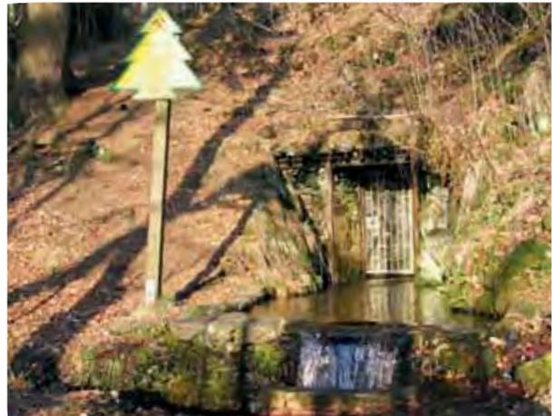
Abb. 4.3: Das Mundloch des St. Annen Stollens (Frühjahr 2009); dieser entwässert bis heute den ausgedehnten Altbergbau im östlichen Teil des Beerbergs.
