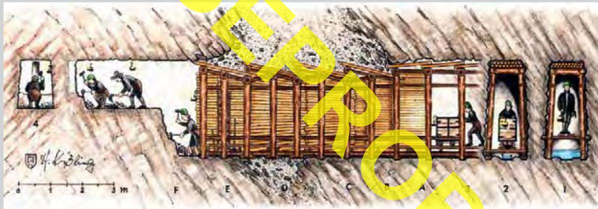
Abb. 2-10: Diese idealisierte Darstellung der Stollenauffahrung im frühen 18. Jahrhundert von Hermann Kießling (2001) zeigt den gestuften Ortsvortrieb mit einer nachgehauenen Strosse, die Durchfahrung eines Verbrauchs mittels einer Getriebezimmerng sowie ein als Wetterscheider fungierendes Tretwerk.
