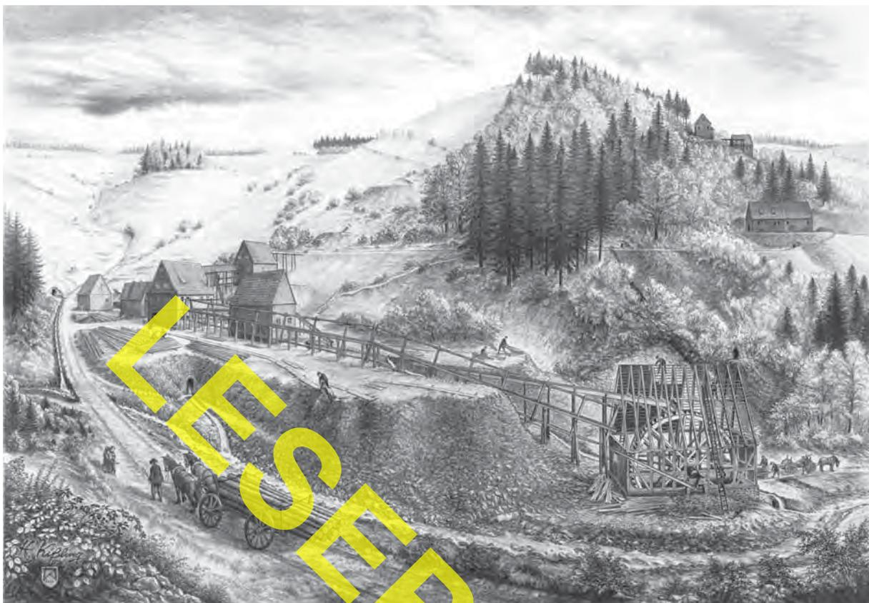
Abb. 2-50: Künstlerische Darstellung der Wennglückter Tagesanlagen nach dem Durchschlag des Sieberstollens (1804/05). Im Vordergrund wird gerade die nicht mehr benötigte untere Kunstradstube abgebrochen. Im Hintergrund rechts sind der Gaipel des Jacobsglückter Schachtes und dahinter die Claus Friedricher Tagesanlagen zu sehen (Hermann KISSLING 2009).
