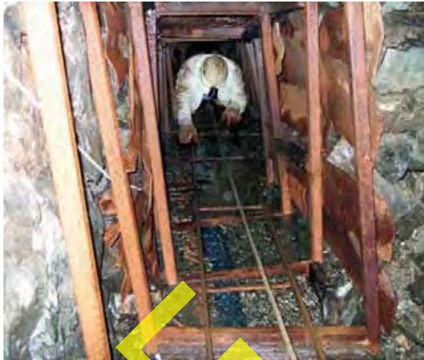
Abb. 4-8: Diese bis 2017 bestehende, nur 0,6 m hohe Engstelle verhinderte lange Zeit eine gezielte Erschließung von Altbergbau im hinteren Teil des St. Annen Stollens (Foto 2011).
