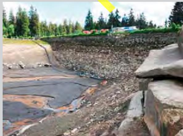
Abb.8-3c: Der Oderteich völlig entleert zur Sanierung des Grundstriegels (2016).
