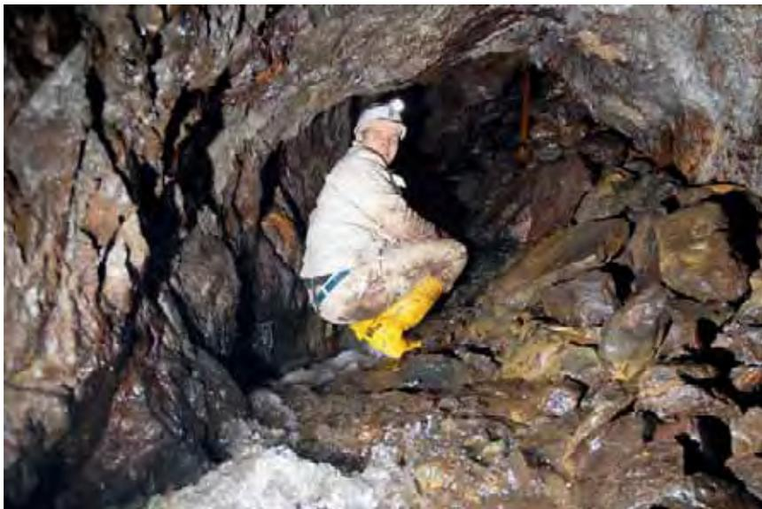
Abb. 2-56: Sieberstollen am Fuß von Absinken 5 auf dem Wennsglückter Gang. Herein gebrochener Versatz, hinter dem sich Wasser staut, versperrt den Zugang zum Neuen Bärener Ort (2012).
