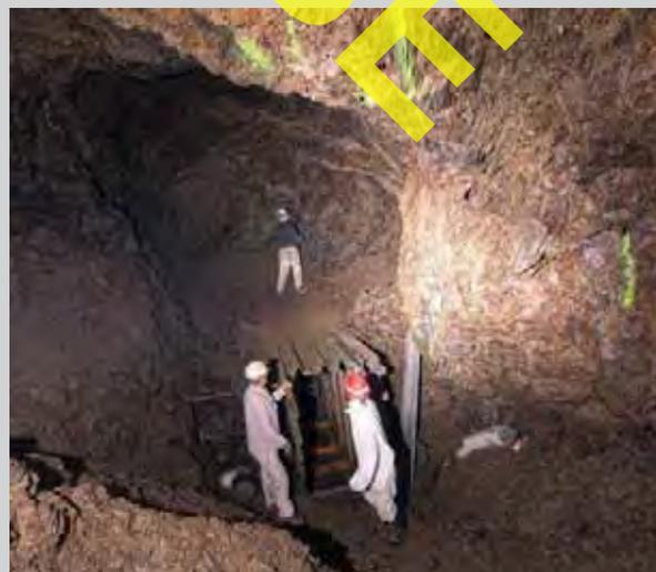
Abb. 6-15 a-b: Arbeiten zur Sicherung des St. Jürgen Stollen im Bereich der Verbruchzone (2015-2017); links: Die im Ruschelgebirge ausgebildete Bruchglocke im Zustand, wie er bei der Stollenaufwältigung angetroffen wurde (2015); rechts: Beginn der Sicherungsarbeiten durch das Einbringen eines stählernen Ausbaus (2017).
